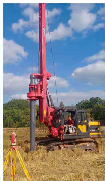
国家电网电塔桩基工程项目
