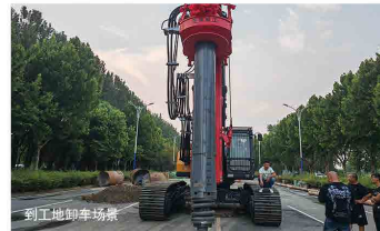
到工地卸车场景
