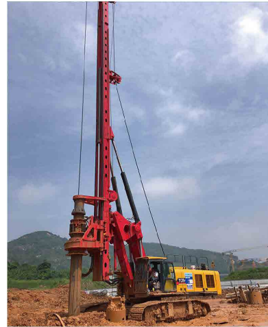
杭州IOT智能物流设施施工项目
