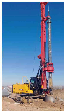
山东潍坊电厂输电线路塔基项目
