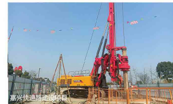
嘉兴快速路建设项目
