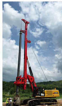
池黄高铁施工项目
