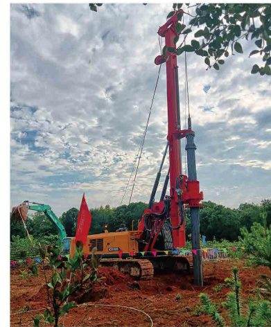
南昌至长沙特高压高安段施工项目
