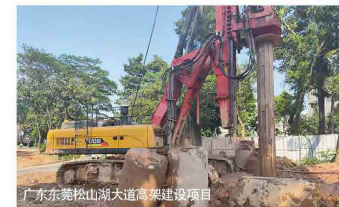
广东莞松山湖大道高架建设项目
